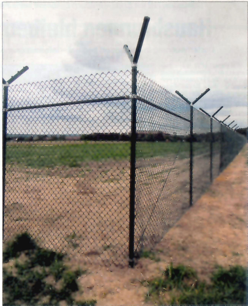
Stoßen auf Unmut im Ansbacher Stadtrat: Die Zaunbauten der US-Armee wie hier an der Shipton-Kaserne. Foto: Albright
